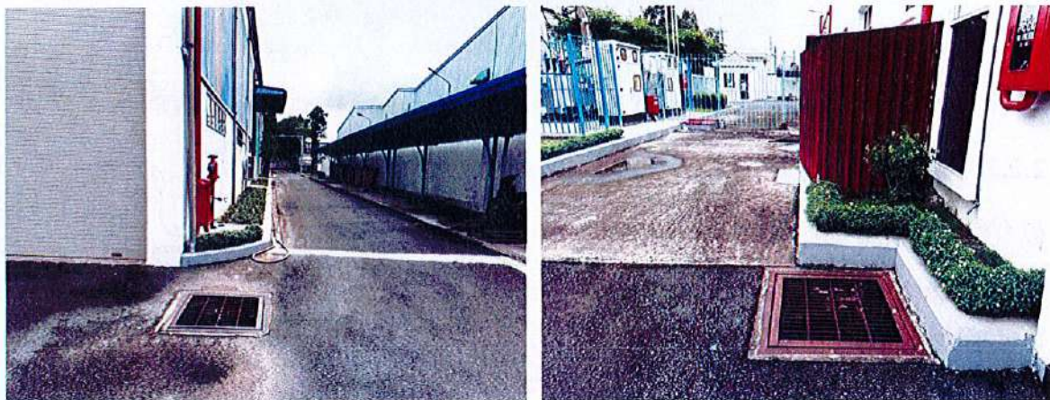
Hình 4.7. Hố ga thu gom nước mưa của Dự án
